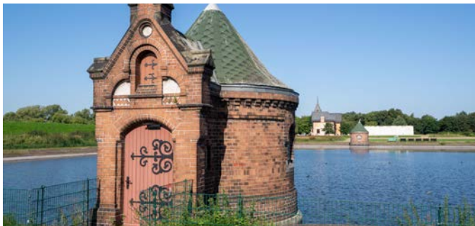
Schaufilterbecken Wasserkunst, Foto: Kraft/ Angerer
